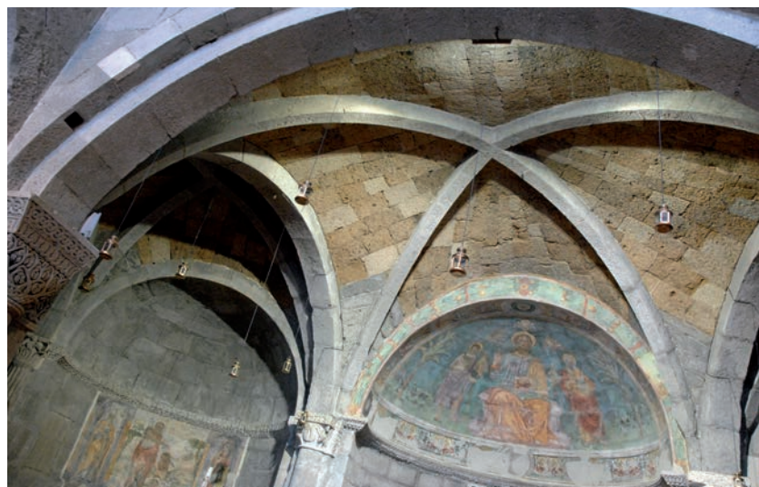
San Flaviano: volte a crociera del presbiterio con costoloni fusiformi databili alla seconda metà del XII secolo
