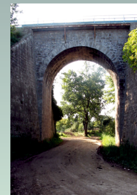
PONTE DELLA FERROVIA
