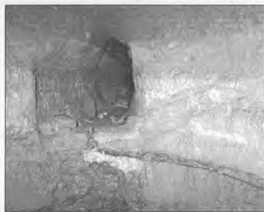
Tratto del cunicolo rimasto inaccessibile dopo lo scavo della cisterna: sono ben visibili i livelli delle falde tufacee e di lapillo, e la canaletta di convogliamento delle acque.
